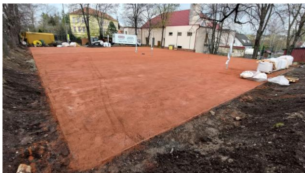
OBRÁZEK Č. 1 – FINÁLNÍ ÚPRAVY OBRÁZEK Č. 2 – INSTALACE ANTUKY
